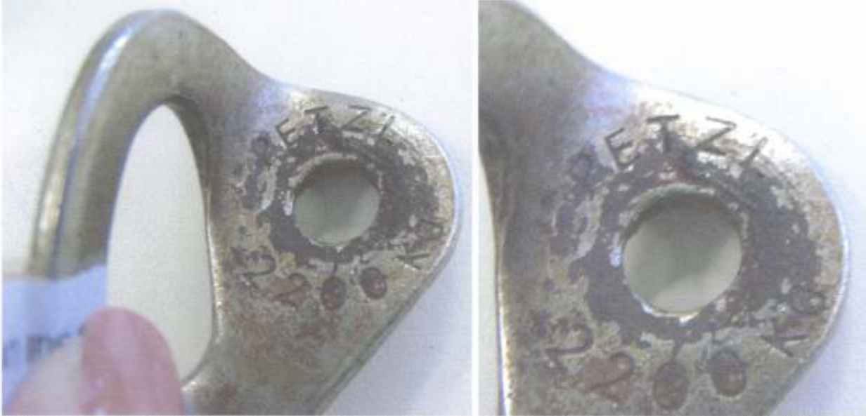
Fotografia 8 – Amostra S-40788 – Chapa PETZL – detalhe da fotografia 07 - Observa-se produto de corrosão (preto), sendo este o ponto com corrosão na união entre o parafuso de fixação e a chapeleta.
